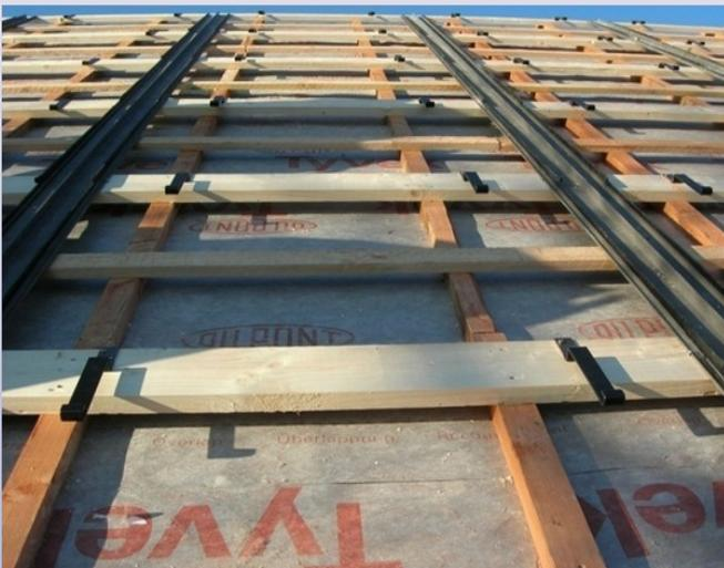
Chaque panneau est fixé, par chevauchement, sur les lattes horizontales avec des crochets recouverts d'un revêtement résistant à long terme aux intempéries.
